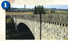
1 Pont sur la Broye 46.705305 / 6.8436275
